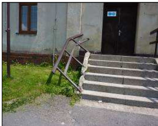
schody do OÚ
