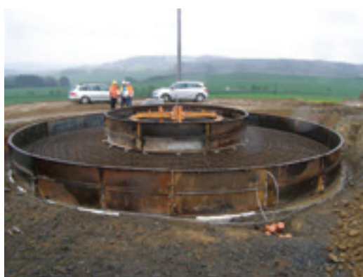
základ VE v Dožicích u Nepomuka
