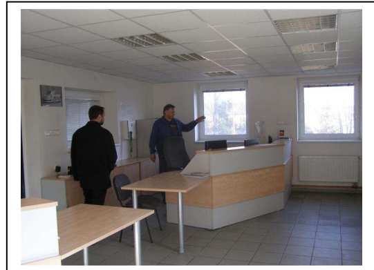
Velín elektrárny v Trhových Svinech ▲
