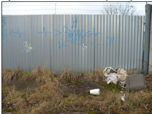
Černá skládka okolí kasáren
