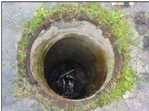
kasárna –kanalizační šachta
