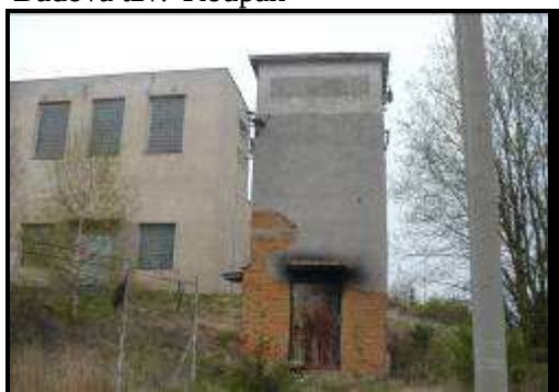
Bývalá trafostanice u staré kotelny.
