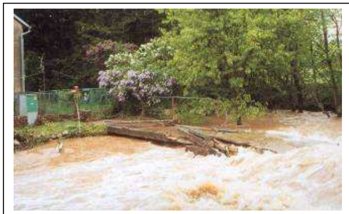
Strašice – bývalý most Padrt'ský potok - 2006 příčina destrukce mostu - 2006
