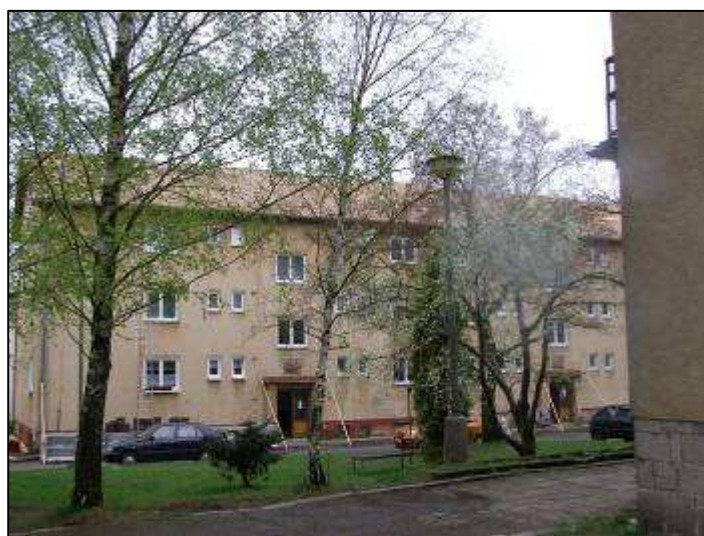
foto z rekonstrukce střechy domu č.p. 450-451 O tom, že to je třeba nelze pochybovat. (foto Ing. Nerad 18.4.2009)
