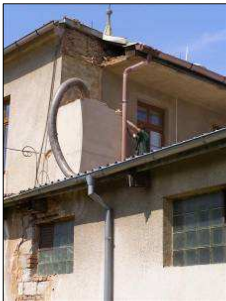
Demolice budovy začala zbouráním komína.
