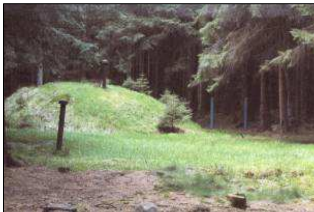
Jímací objekt vodovodu pro Vodohospodářské sdružení Rokycanska (foto Ing. Nerad – 2005)
