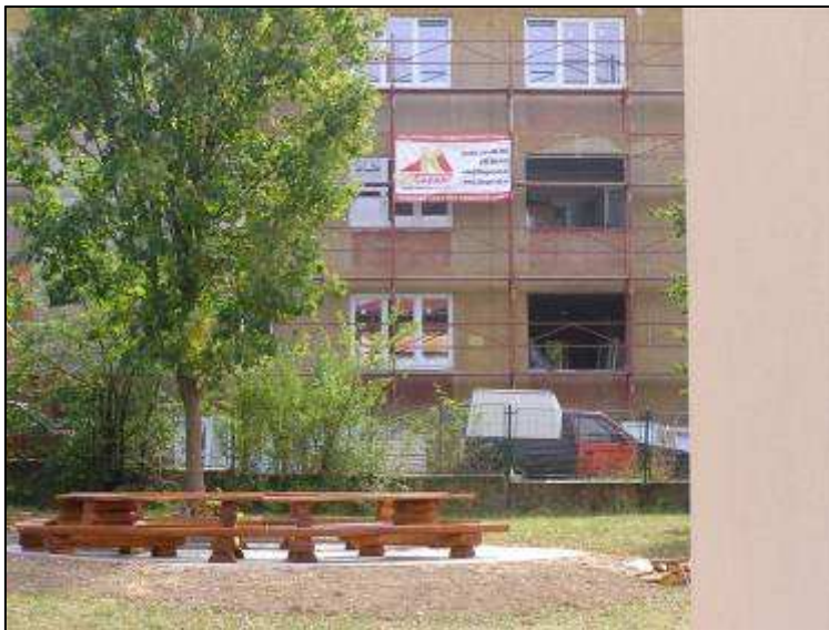
Opravená škola a opravované bytovky – 09/ 2009 – foto Ing. Neraď
