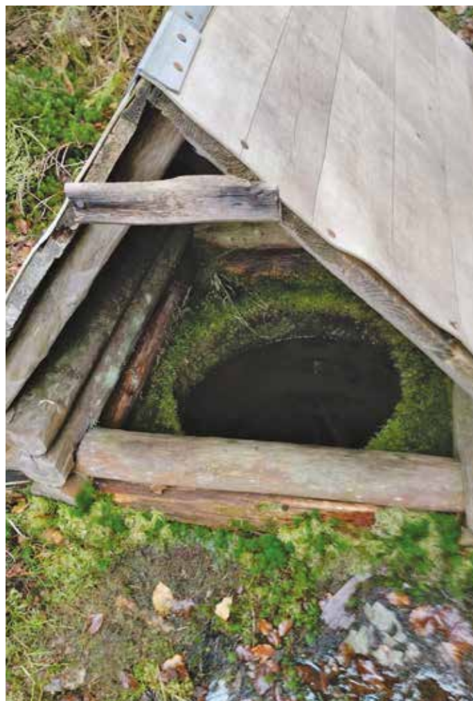
Studánka pod Březovým vrchem
