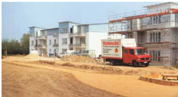
Výstavba sídliště sociálních bytů v Lübecku
