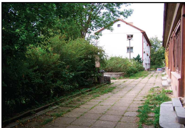
Nevhodné použití vysokých keřů před obchodem, zarůstání dlaždic trávou
