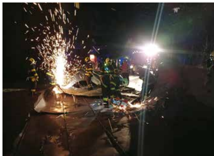
Likvidace stržené střechy ve Strašicích
