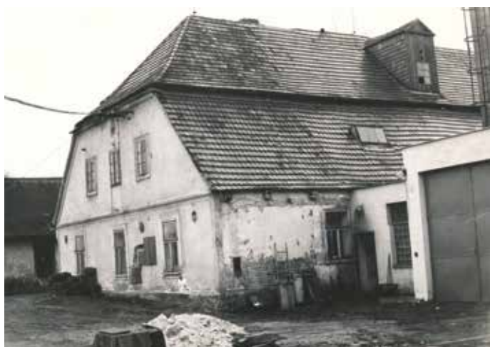
1985 – Mikulíkův mlýn před demolicí
